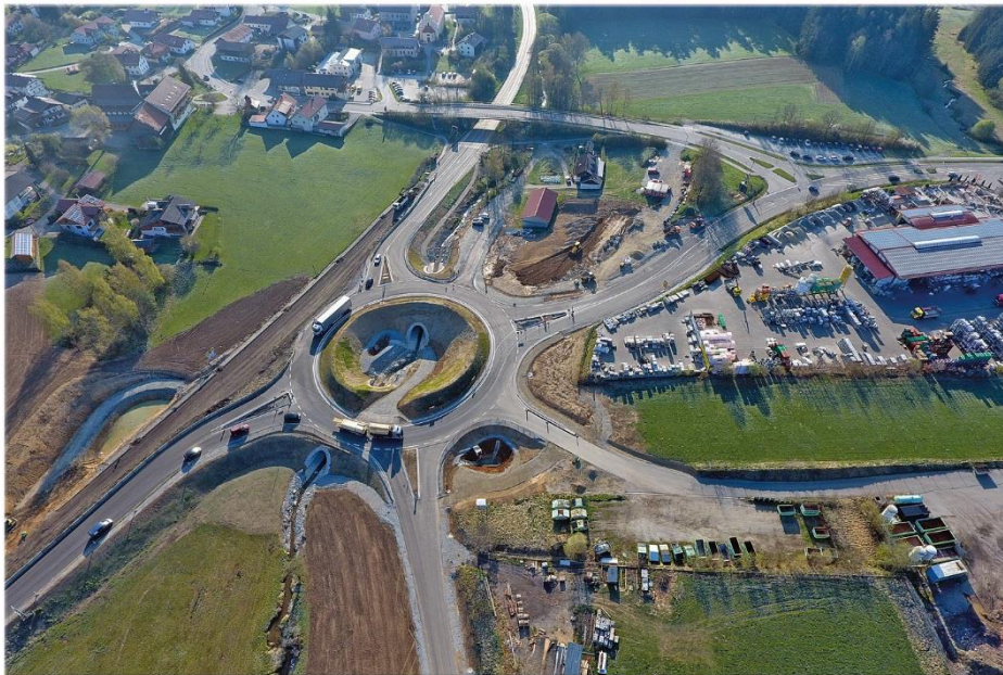
Fertigstellung der Kreuzung Patersdorf im Mai 2017
